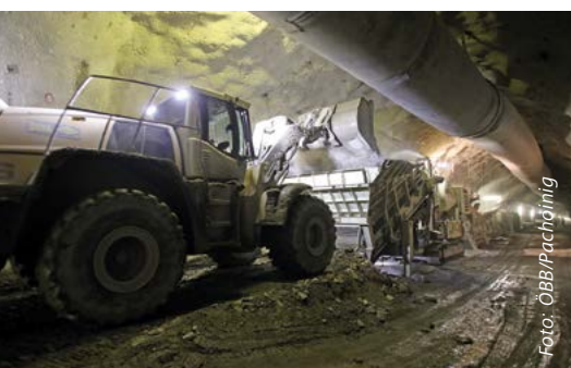
Zyklischer Vortrieb im Berg
