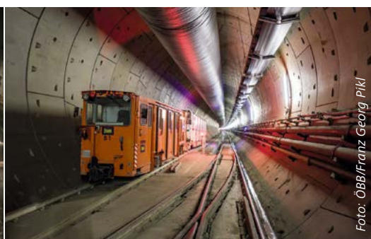
Ein Blick ins Innere des Koralmtunnels
